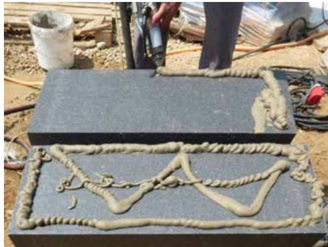
Rendszerragasztó gépi felhordása W-séma szerint
