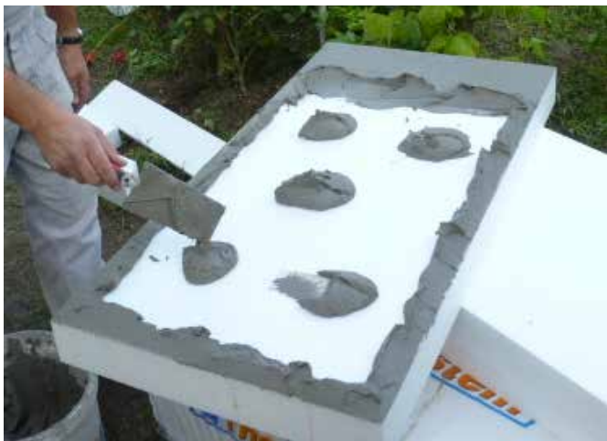
Rendszerragasztó kézi felhordása pont-perem módszerrel
