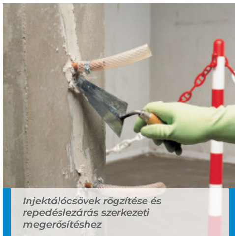
Oszlop kezelése Adesilex PG1-gyel
