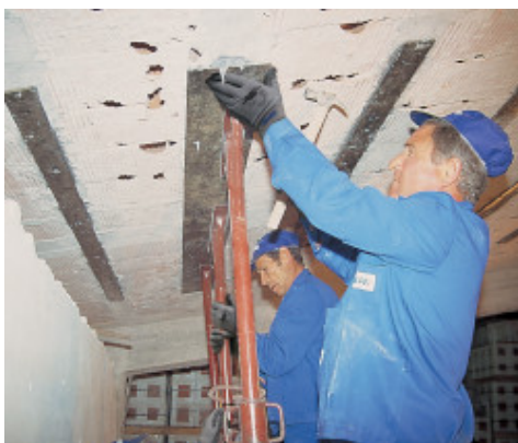
Fémlemek beépítése lemezzátétes szerkezeti megerősítéshez
