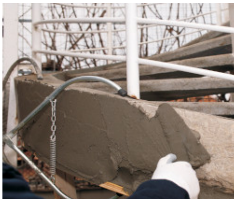
Mapegrout 430 Zero bedolgozása kézzel
