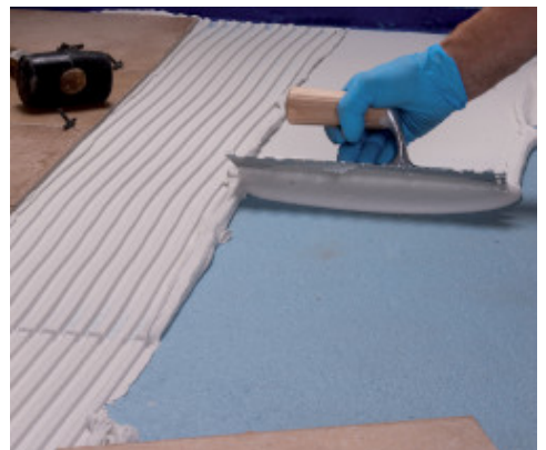
Burkolólapok ragasztása a Mapelastic AquaDefense Zero-ra
