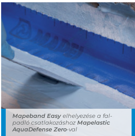
Az első réteg Mapelastick AquaDefense Zero felhordása esetrichre
