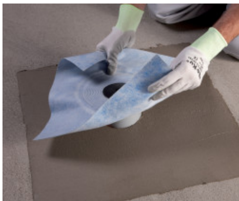
Drain Vertical elhelyezése Mapelastic Zero-n
