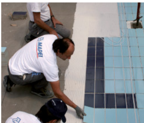
Kerámia burkolólapok fektetése Mapelastic Zero -ra úszómedencében
