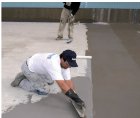
Úszómedence vízszigetelése Mapelastic Zero -val
