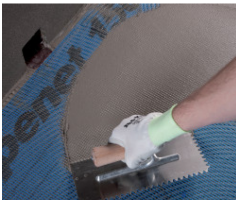
Mapelastic Zero felhordása Mapenet 150-re
