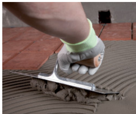
Granirapid felhordása Mapelastic Zero -val vízszigetelt teraszon
