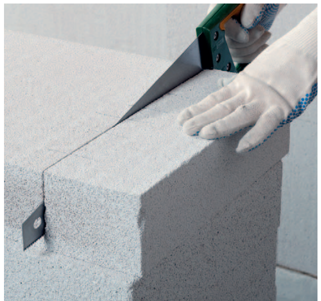
Hőszigetelő lapok méretre szabása
